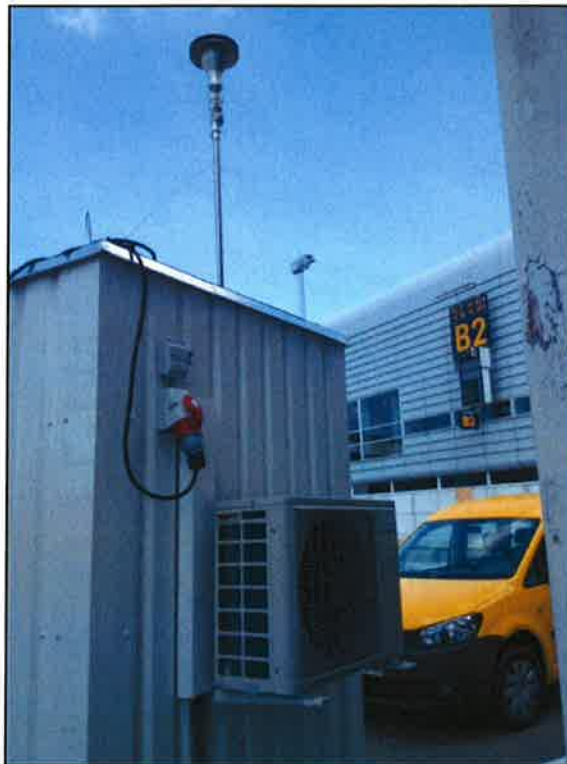
Figur 3. Målestation på forpladsen ved B4.
